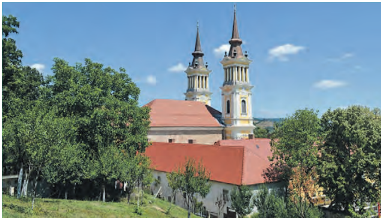
Die Wallfahrtskirche Maria Radna erstrahlt nach Abschluss der umfassenden Renovierungsarbeiten in neuem Glanz. Am 2. August fand die feierliche Segnung der renovierten Basilika statt. Foto: Pfarrei Maria Radna
